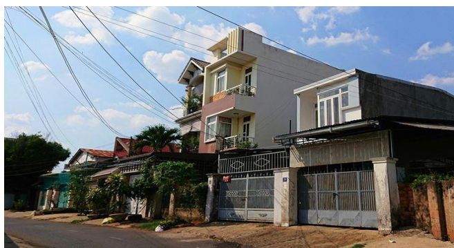
Dãy nhà ngay cạnh nhà Bí thư Tỉnh ủy Đắk Lắk xây không phép dọc đường Tô Vĩnh Diện
